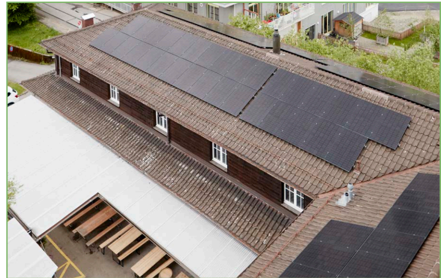
Photovoltaikanlage am Produktionsstandort in Bern (Photoarchiv Blaser-Gruppe)
