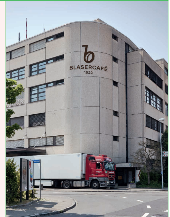
Firmensitz an der Güterstrasse 4 in Bern (CH)
