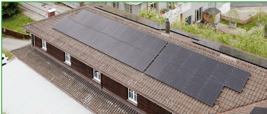
Photovoltaikanlage am Produktionsstandort in Bern (Photoarchiv Blaser-Gruppe)
