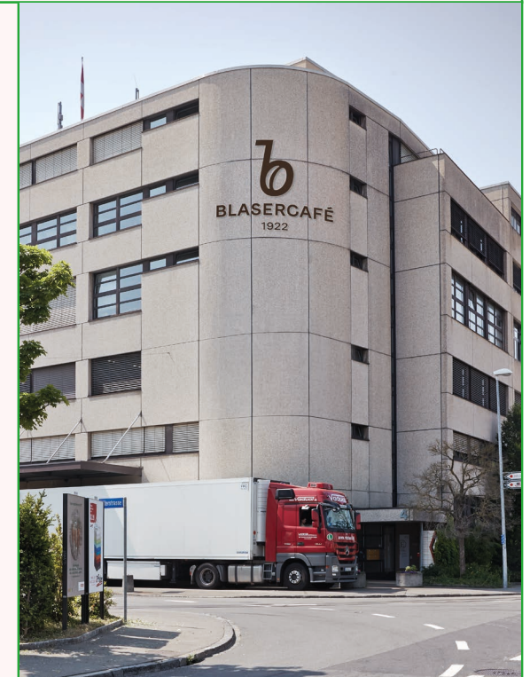
Firmensitz an der Güterstrasse 4 in Bern (CH)
